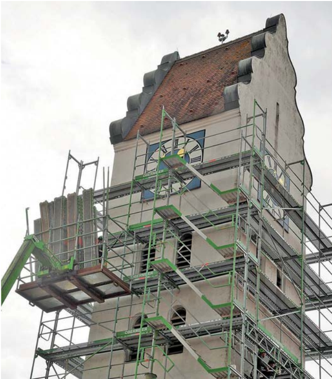
20 Wochen werden die Sanierungsarbeiten des Oberstimmer Kirchturms dauern.
