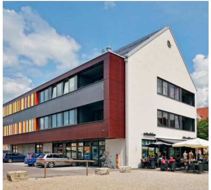
Die neue Bibliothek in Manching wird mit Erdwärme beheizt und gekühlt.
