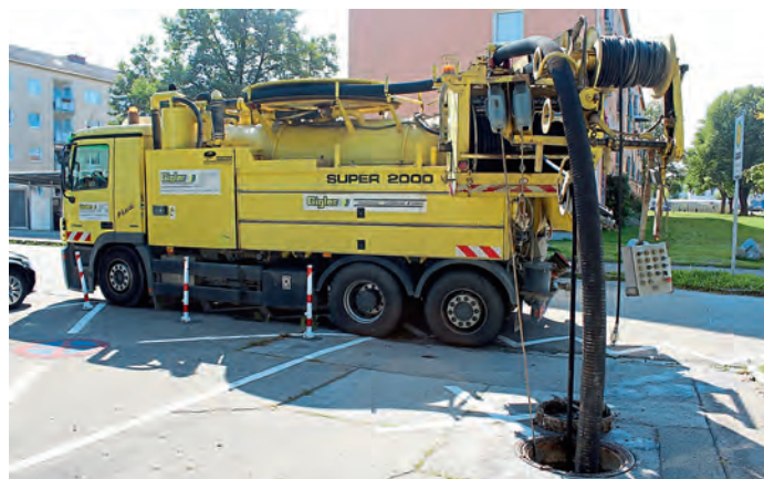
Mit einem Spezialfahrzeug werden die Revisionschächte durchgespült.
