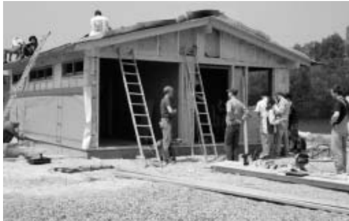
Wasserwachtler beim Bau der neuen Wachstation in Forstwiesen
