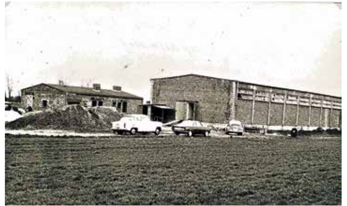
Das alte Manchinger Wasserwerk von 1964 kurz vor der Vollendung.
