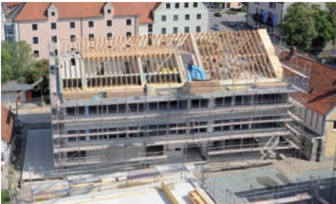
Dachstuhl für die neue Bibliothek, nun geht es an den Innenausbau.
