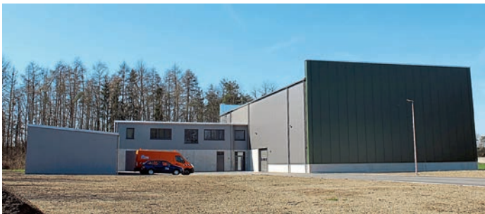
Das neue Wasserwerk im März 2020 mit Garage, Betriebsgebäude, Maschinenhalle und Fahrzeugen Foto: Markt Manching (ScS)
